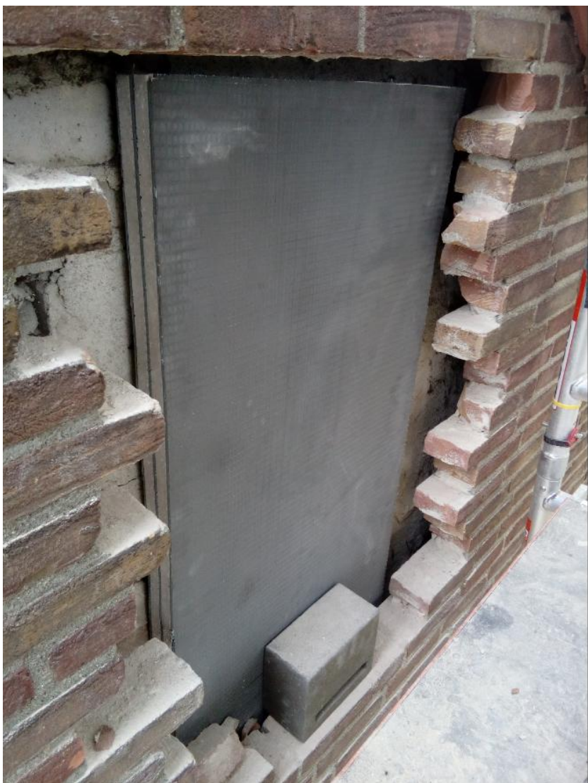
Vleermuisverblijf in gevel met inbouwmodule Miecon en entreesteen. Bron: Arcadis
