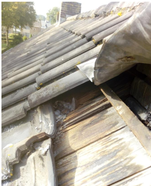
Voorbeeld gierzwaluwnest onder dakpannen. In dit geval toegang via kantpan of loodflap bij schoorsteen. Project St. Joseph in Boxtel. Bron: Arcadis
