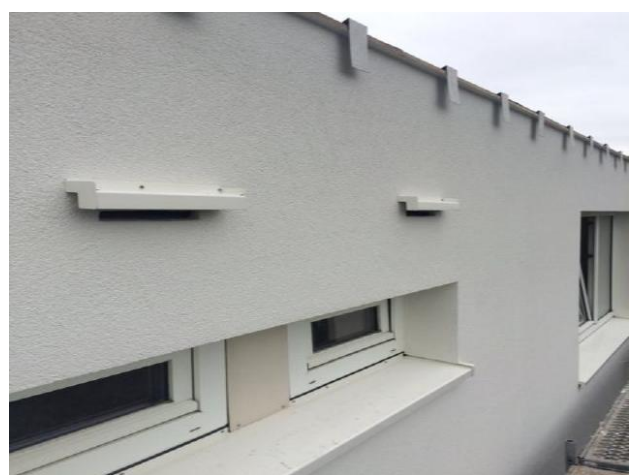
Voorbeeld vleermuisverblijf in de voorgevel. Bron: Ecologisch werkprotocol veld Eijsden – Arcadis.
