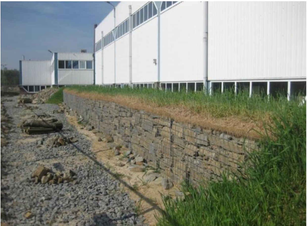
Reptielenschanskorf (ontwerp en na aanleg) als verblijfplaats voor de muurhagedis. Project Belvedere, Maastricht. Bron: Arcadis
