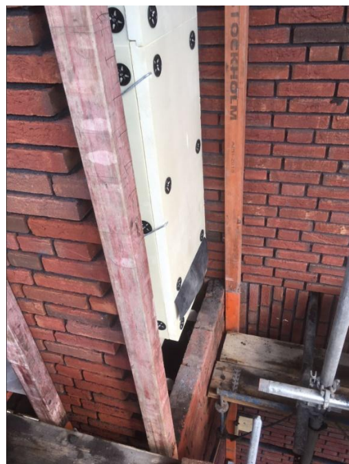
Uitvoeringsvoorbeeld project Walewyc te Waalwijk met foto's van de vleermuiskast ten behoeve van massa-winterverblijf
