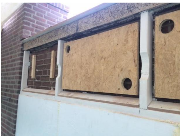
Voorbeeld vleermuisverblijf in de voorgevel. Bron: Ecologisch werkprotocol veld Eijsden – Arcadis.
